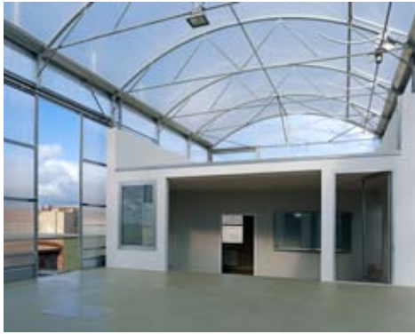
温室大棚结构内的加建结构把“顶上房屋”分为两层，依季节特点做客厅或阳台(上图)。从外部看，“顶上房屋”与原结构的契合异常绝妙(下图)
