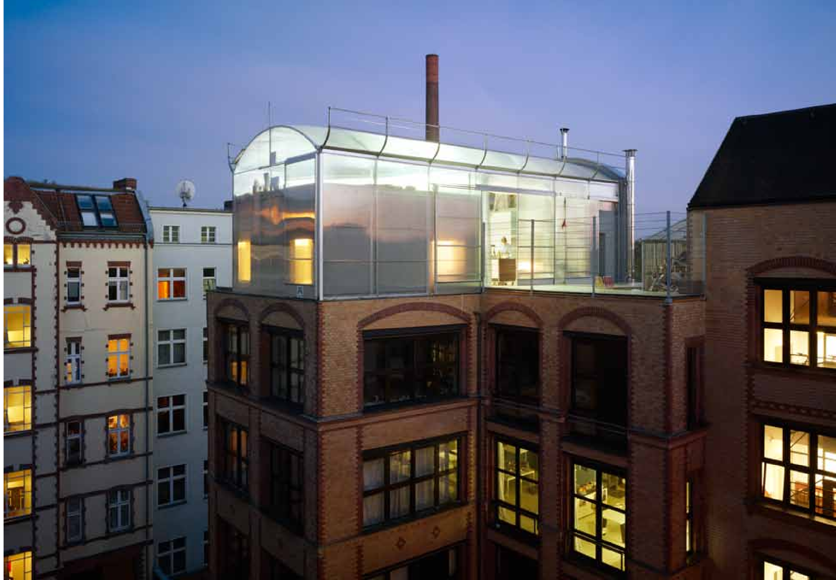
Oben: Das ist ein Blindtext Heizsystem durch optimale passive Solarenergienutzung mittels Gebäudeorientierung und Fassade
