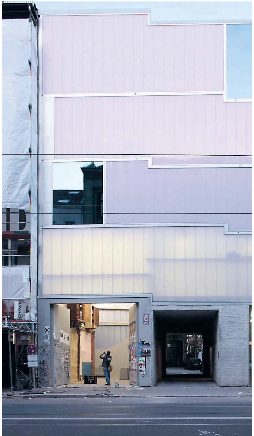
Ein Haus aus dem Baumarkt: Die Fassade des Berliner Galeriehauses in der Brunnenstrasse besteht aus Stahlrohren und ein Treppengeländer aus Stahlrohren.
